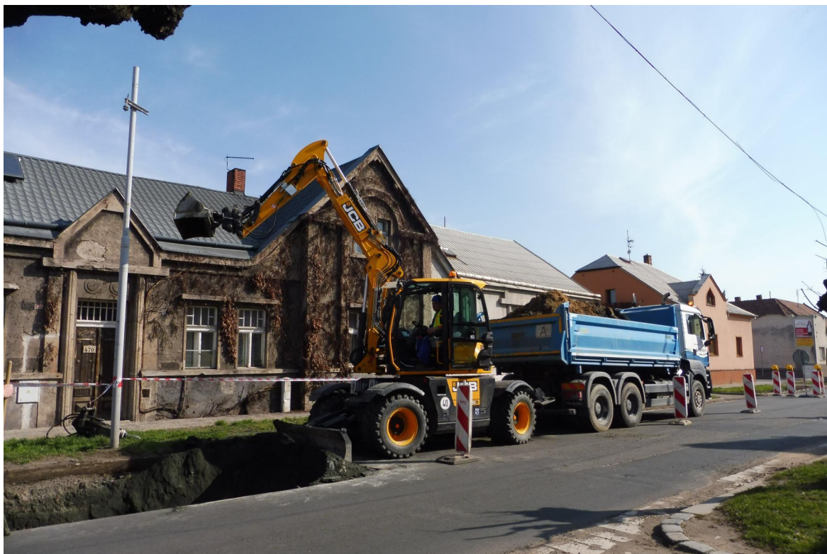
Foto č. 3: Hloubení zemní jámy při odstraňování poruchy na kanalizačním potrubí, březen 2021.
