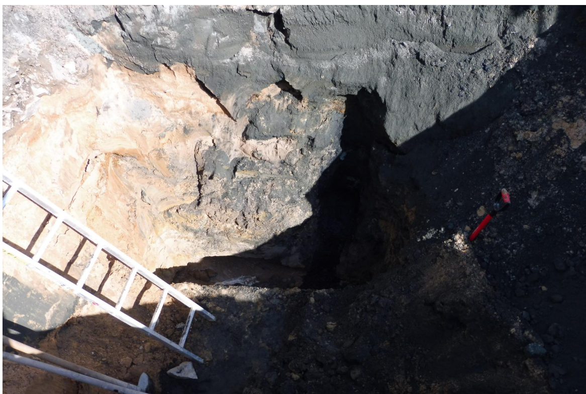
Foto č. 4: Vyhluoubená zemní jáma při odstraňování poruchy na kanalizačním potrubí. Hliníkový žebřík stojí na povrchu hlavní stoky potrubí, v pohledu za ním je odtěžena zemina do hloubky 3,2 m pod terén s ustálenou hladinou podzemních vod nade dnem (na snímku málo zřetelnou).
